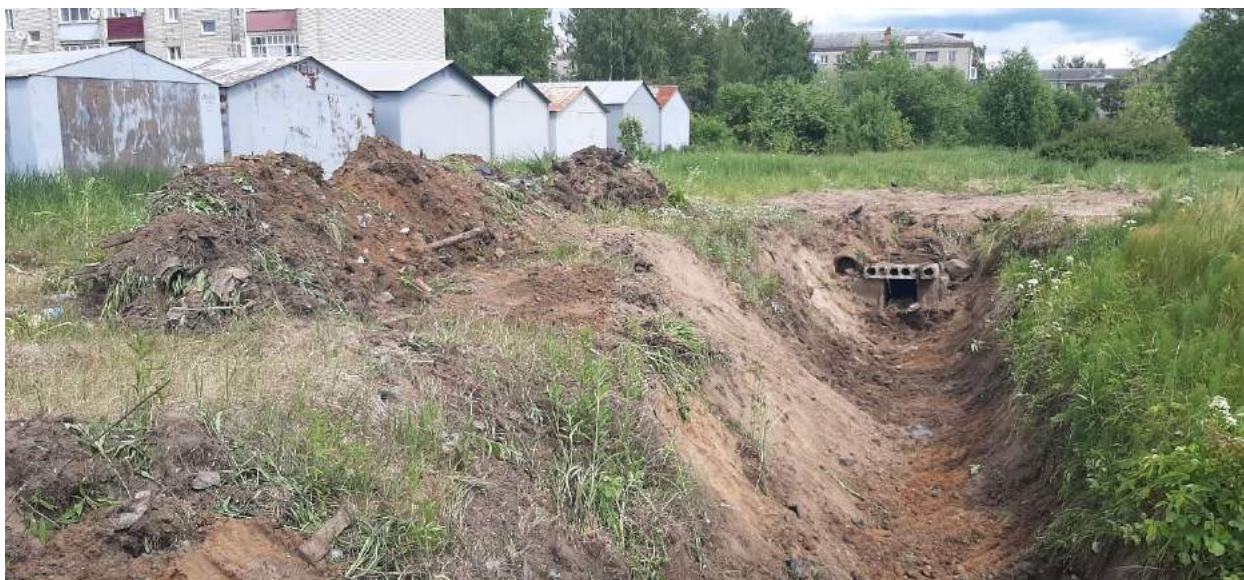
Установлена дополнительная плита через канаву для пешеходов
