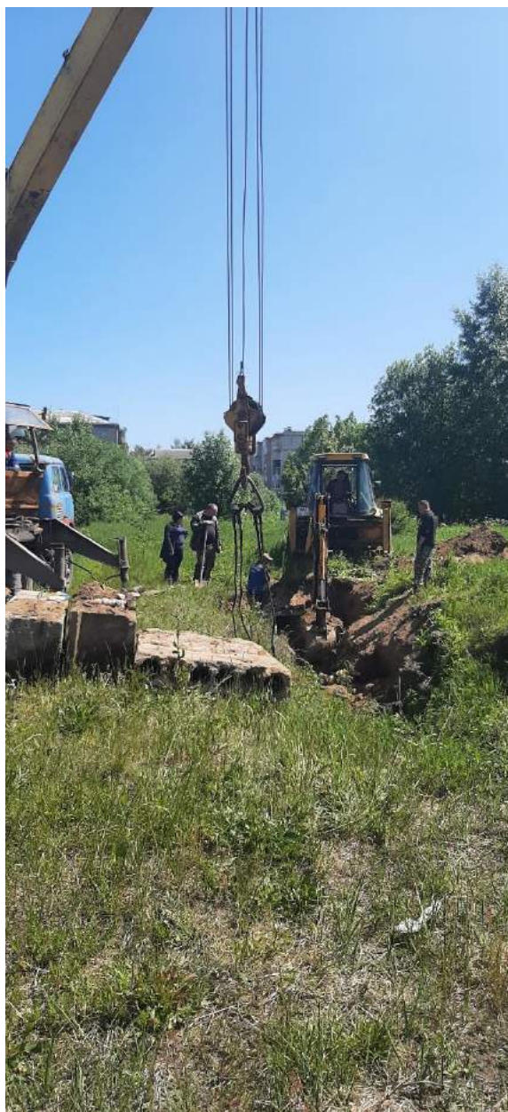
13. Выполнение работ по реконструкции линии уличного освещения пешеходного перехода, расположенного на перекрестке ул. Лермонтова и ул. Пушкина г. Южа. (установлен дополнительных ж/б столб и 1шт. светодиодный светильник с кронштейном)
