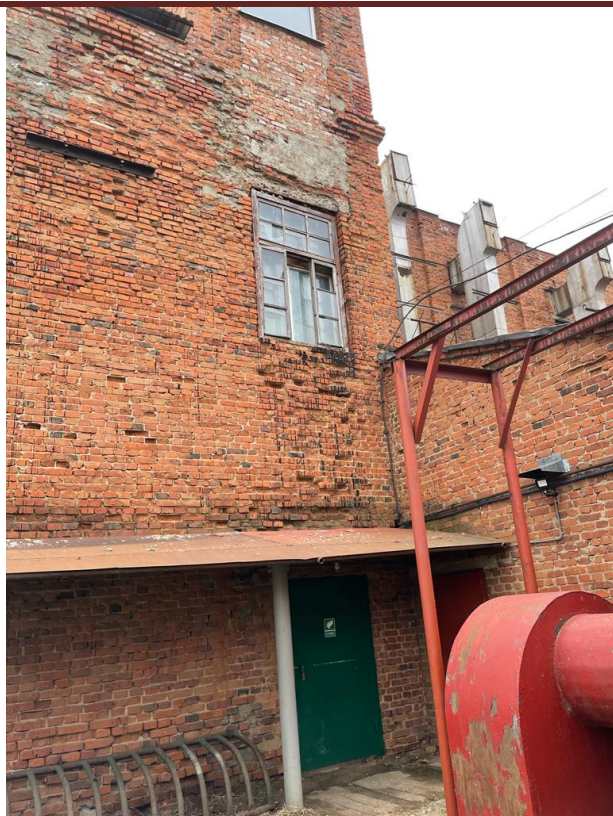
Рисунок 7 – Внешнее состояние котельной № 1 (г. Южа, ул. Советская, д. 44)
