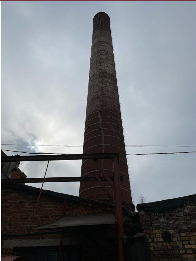
Рисунок 5 - Труба котельной № 1 (г. Южа, ул. Советская, д. 44) 1911 г. постройки
