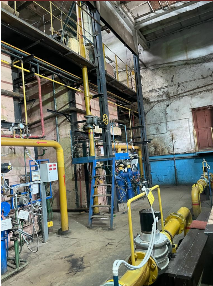
Рисунок 6 – Внутреннее состояние котельной № 1 (г. Южа, ул. Советская, д. 44)
